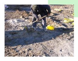
El proceso de carga se inicia con la comprobación de todos y cada uno de los barrenos, de sus buenas condiciones para la carga, asegurándonos que no hay atranques que impidan el paso de los explosivos y accesorios, o presencia de agua, en cuyo caso se procurará extraerla, o si no fuera posible, utilizar el explosivo adecuado resistente a la misma, lo cual se debe haber previsto.
